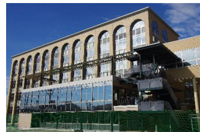
【修文大学 看護学部棟・学生会館】
